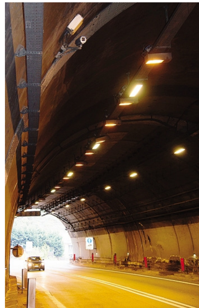
L'ingresso nord della galleria «Love» sulla statale 42
