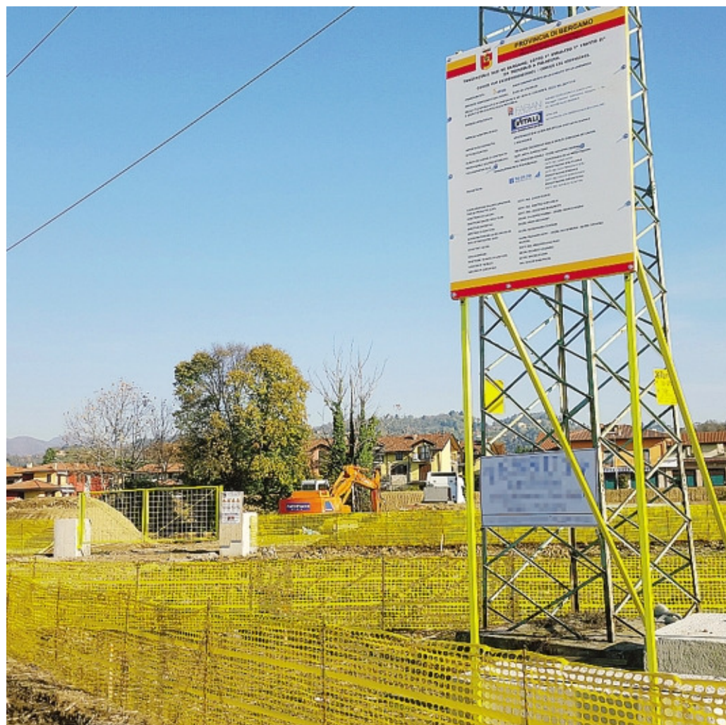
Il cantiere sulla Treviolo-Paladina al confine tra Mozzo e Valbrembo
