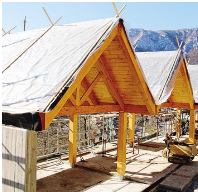
Il «Giardino sensoriale» in costruzione al «Don Palla»
