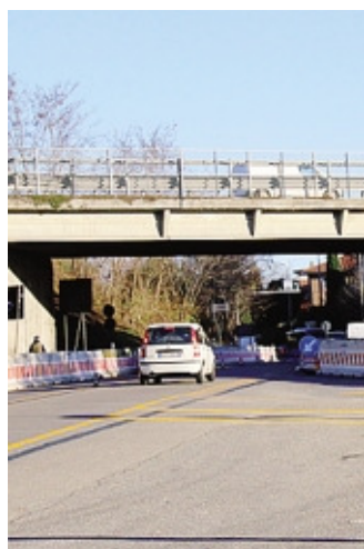
il ponte sulla Briantea
