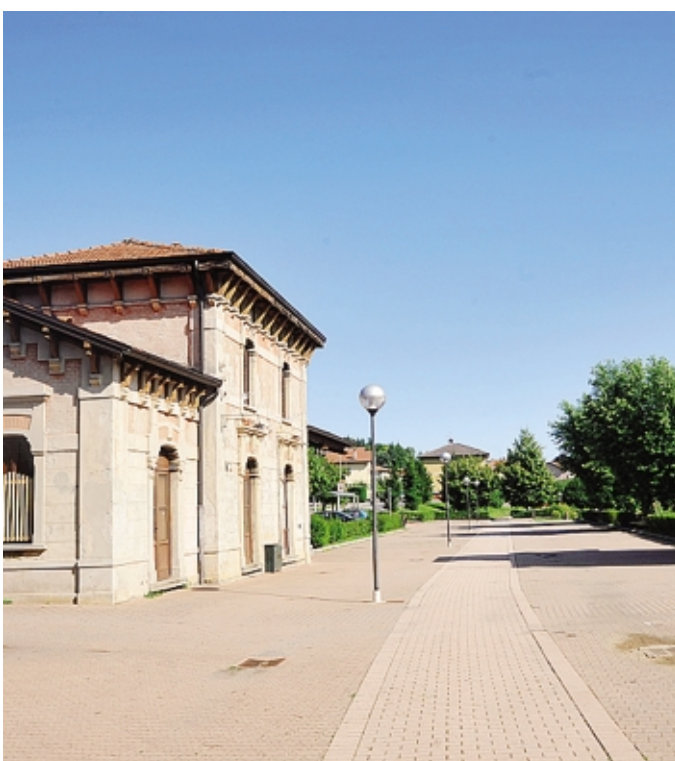
L'ex stazione di Ponteranica dove dovrebbe passare la linea T2
