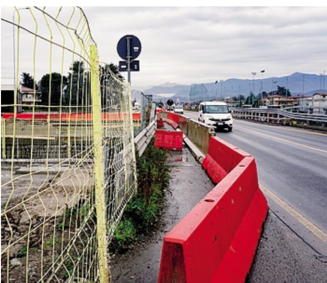
Il cantiere sulla Treviolo-Paladina
