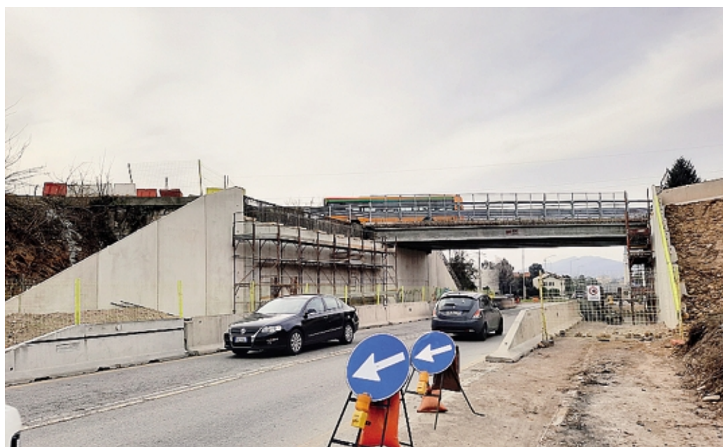
Il cantiere per la Treviolo Paladina a Valbrembo
