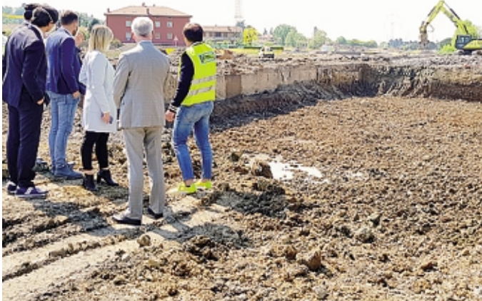
Il sopralluogo delle autorità al cantiere della Treviolo-Paladina
