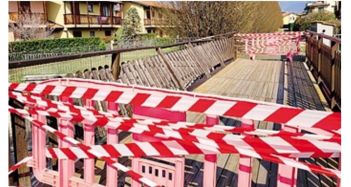
La passerella ciclopedonale di via Leonardo da Vinci chiusa al traffico
