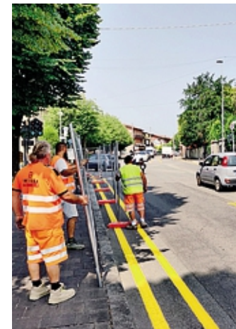
Il cantiere della rotatoria
